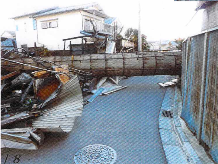
津田沼地区 煙突が倒壊・火災発生
