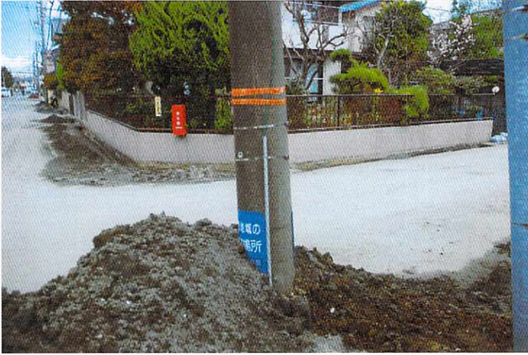
袖ヶ浦地区 埋没した電柱
