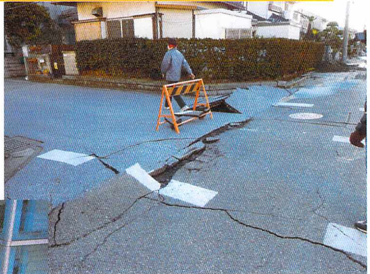
香澄地区 通行不能となった道路
