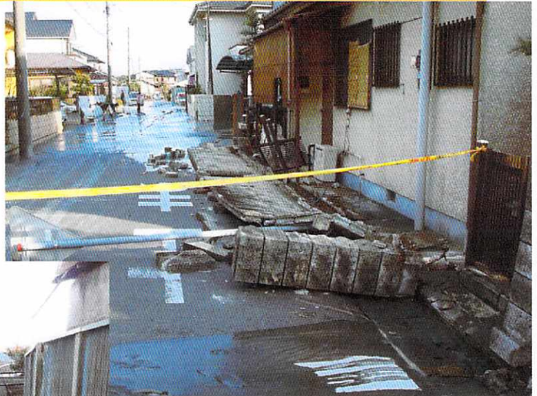
香澄地区 倒れたブロック塀と交通標識
