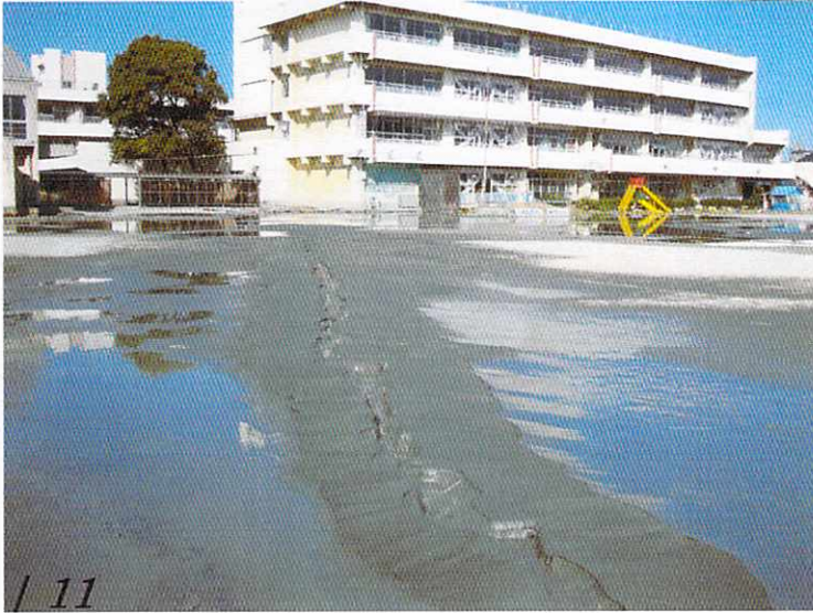
校庭地盤被害
