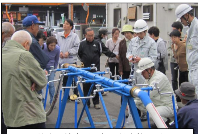
給水訓練会場に仮設給水栓設置
