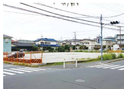
「ドラックストアが建設される旧ゆうゆう館跡地」
