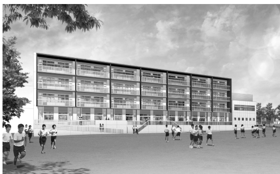
【左図】グラウンド側から見た校舎
