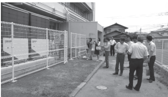
室外機の設置状況を確認
