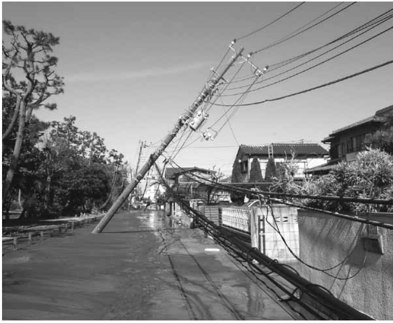
3月11日の東北地方太平洋沖地震による液状化被害（袖ヶ浦6丁目）
