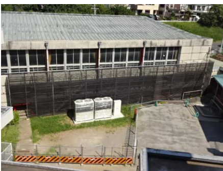
【体育館の空調工事も順調です】
