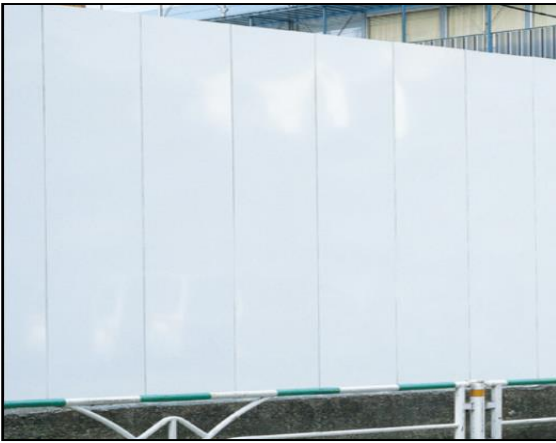
成形板による仮囲い(工事現場周囲に設置)
