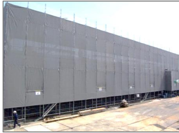
外部足場用メッシュシート(建設中の建物周囲に設置)
