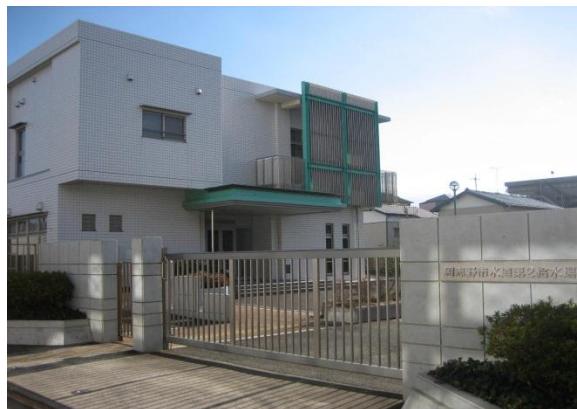
第2給水場（鷺沼台1丁目）
