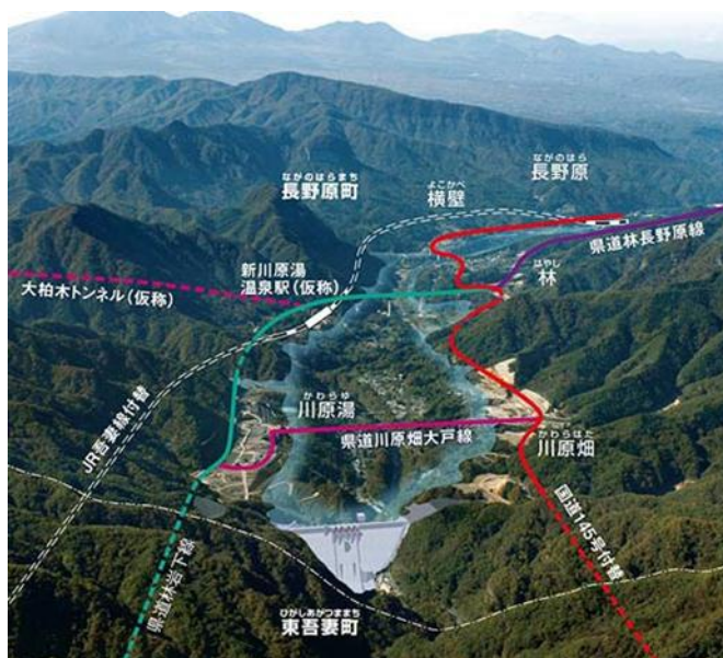
ハッ場ダムの全景
