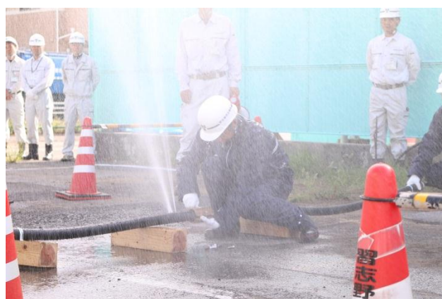
災害復旧訓練
