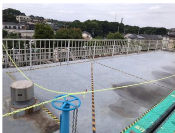
第2給水場№2酸化槽天井 外部写真
