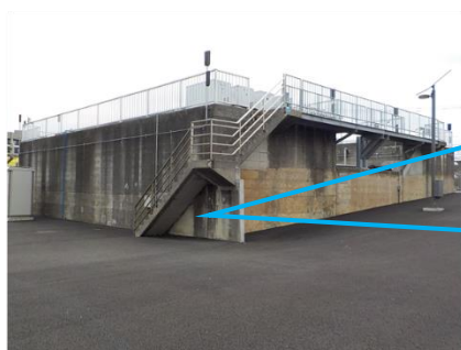
第1給水場着水井・酸化槽・ろ過ポンプ井 全体写真
