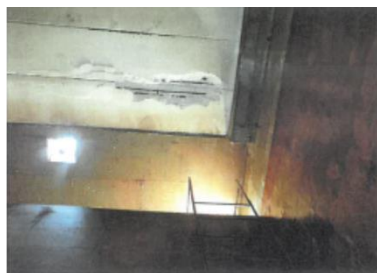
第2給水場№2酸化槽天井 内部写真1
