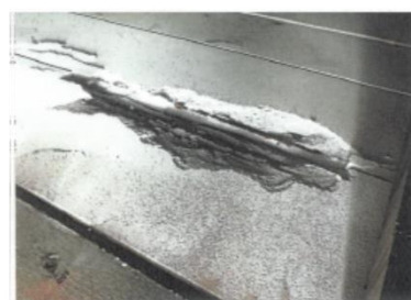
第2給水場№2酸化槽天井 内部写真1 拡大写真
