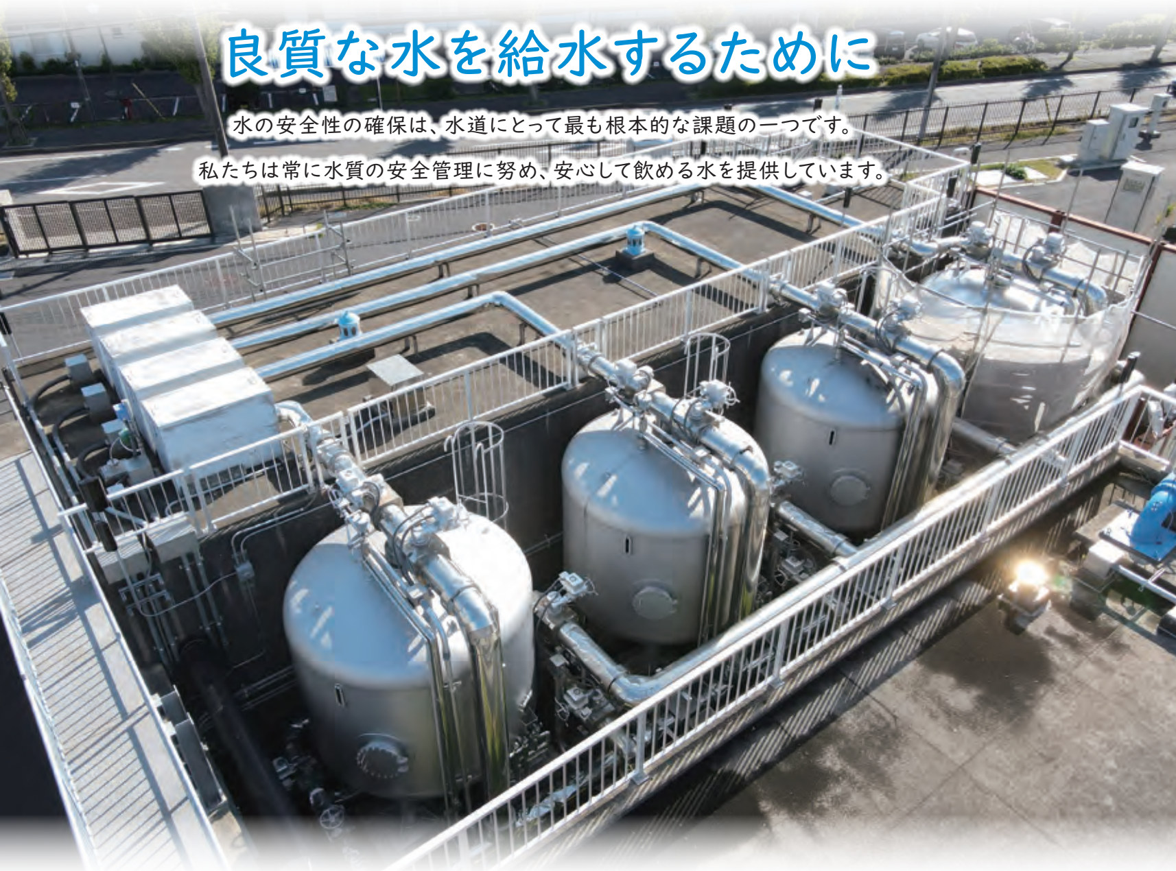
第1給水場急速ろ過装置
