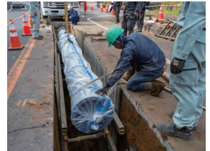
水道管の耐震化工事
