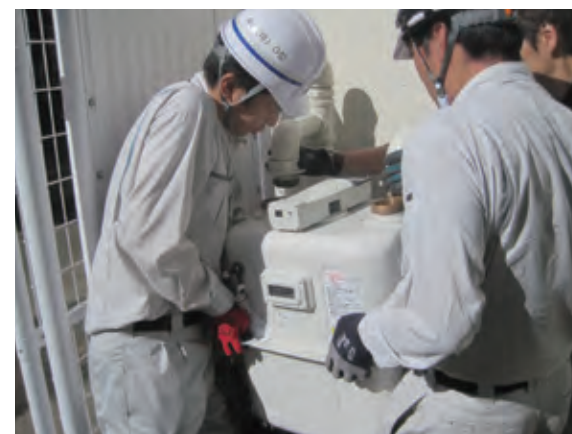
ワークトライアル研修（メーター交換）の様子
