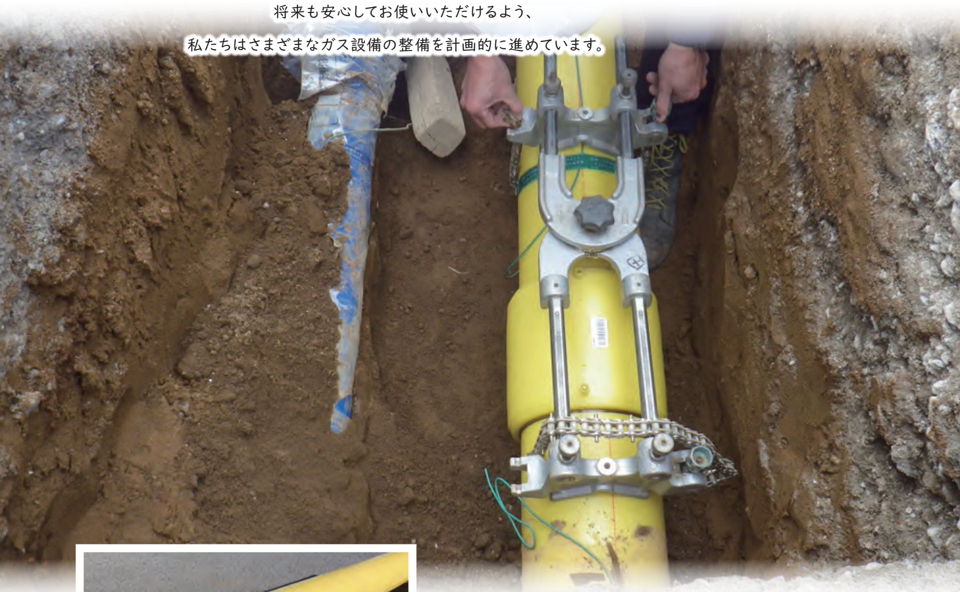
ガス管の耐震化工事
