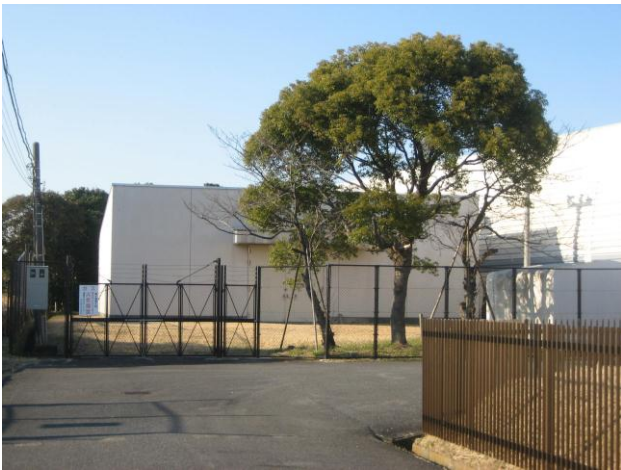
外国産天然ガスを受け入れている施設 (袖ヶ浦6丁目)
