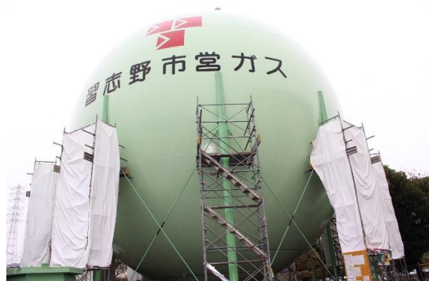
耐震工事の様子
