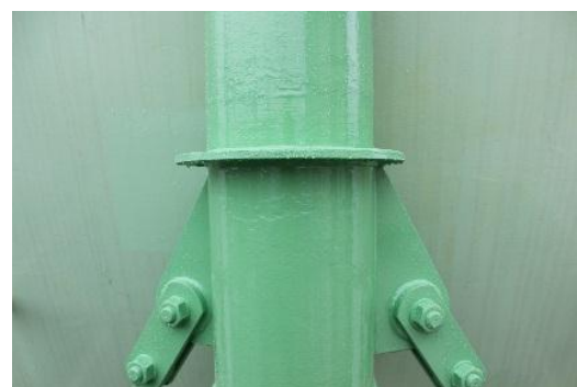
支柱耐震補強の様子(左:補強金具取付 右:補強完了後)
