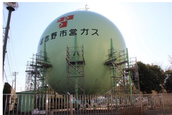
耐震工事の足場の様子
