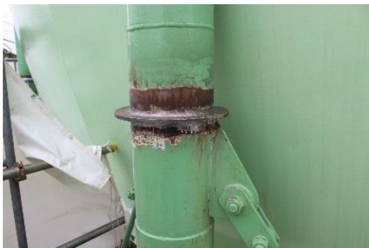
支柱耐震補強の様子(左:補強金具取付 右:補強完了後)
