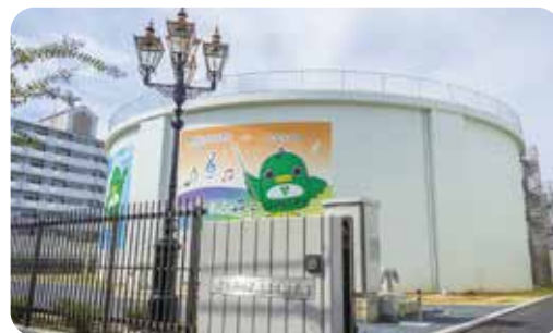
第4給水場の配水池→
