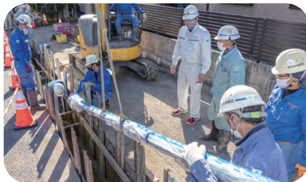
水道管の更新工事の様子
