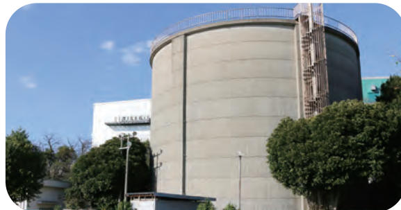
第3給水場の配水池
