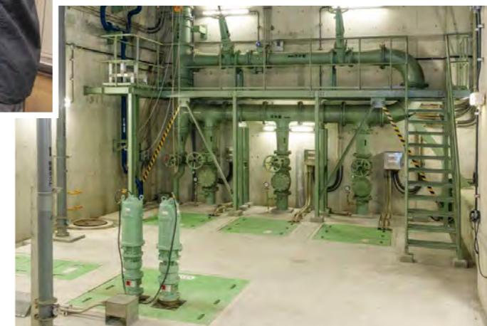
袖ヶ浦汚水中継ポンプ場
