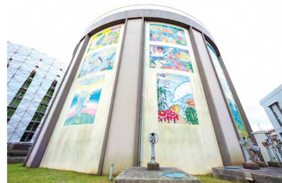
第2給水場配水池
