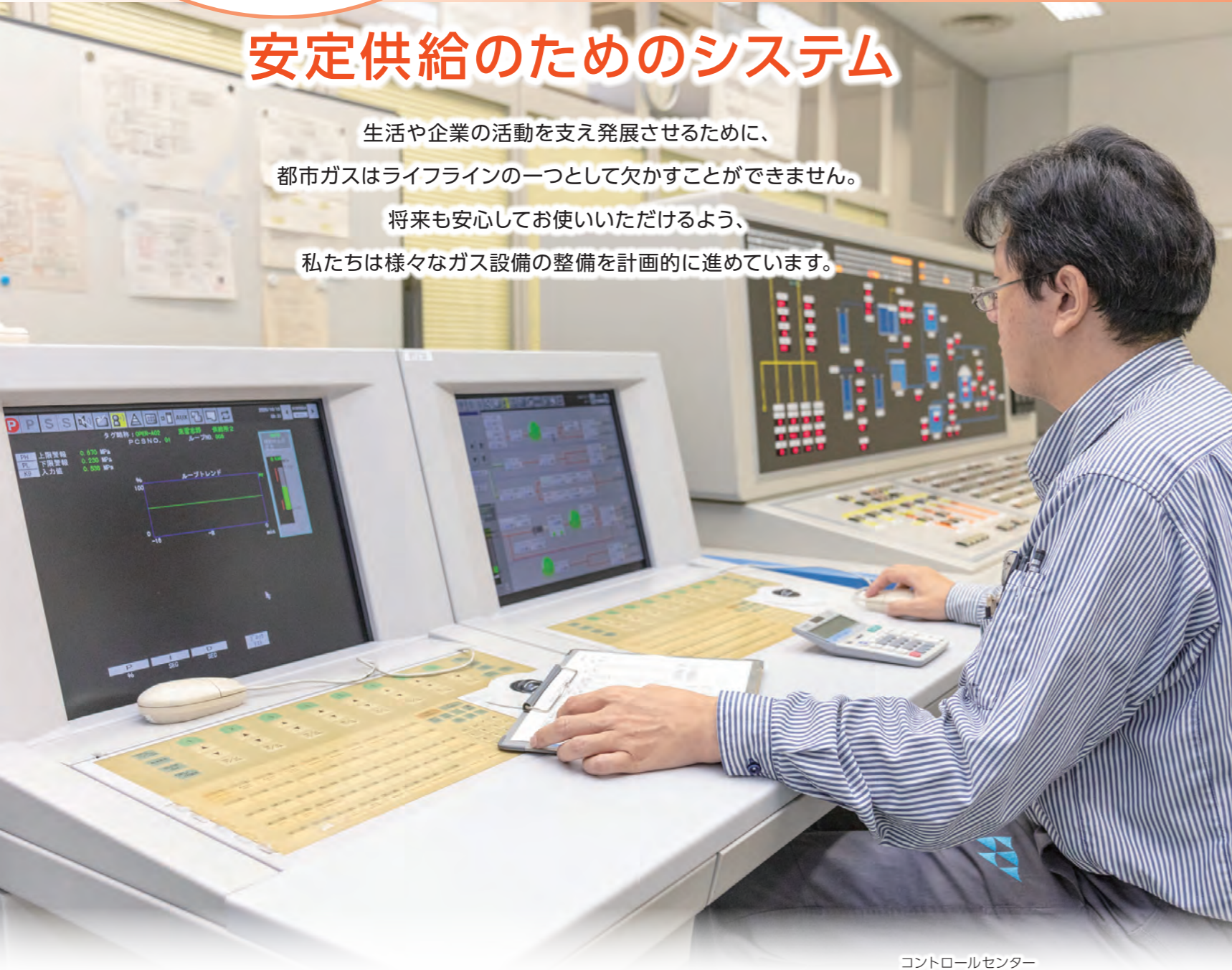
コントロールセンター
