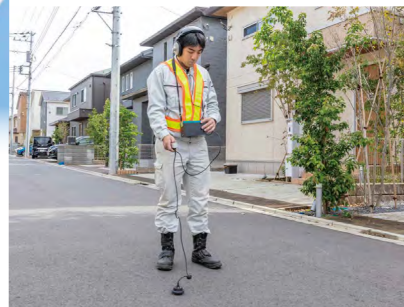
漏水調査（路面音聴調査）
