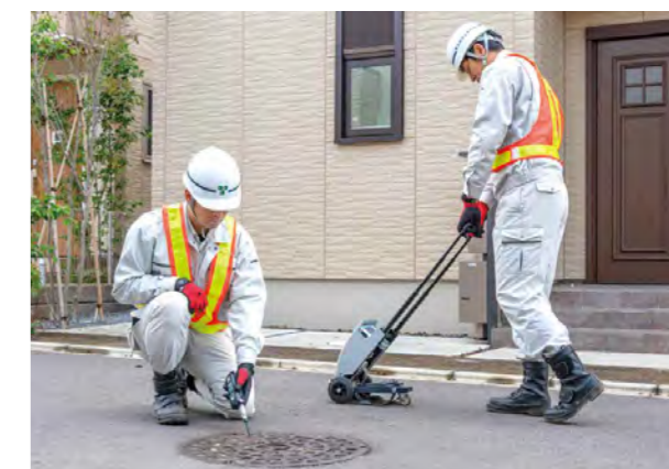
ガス漏れ調査
