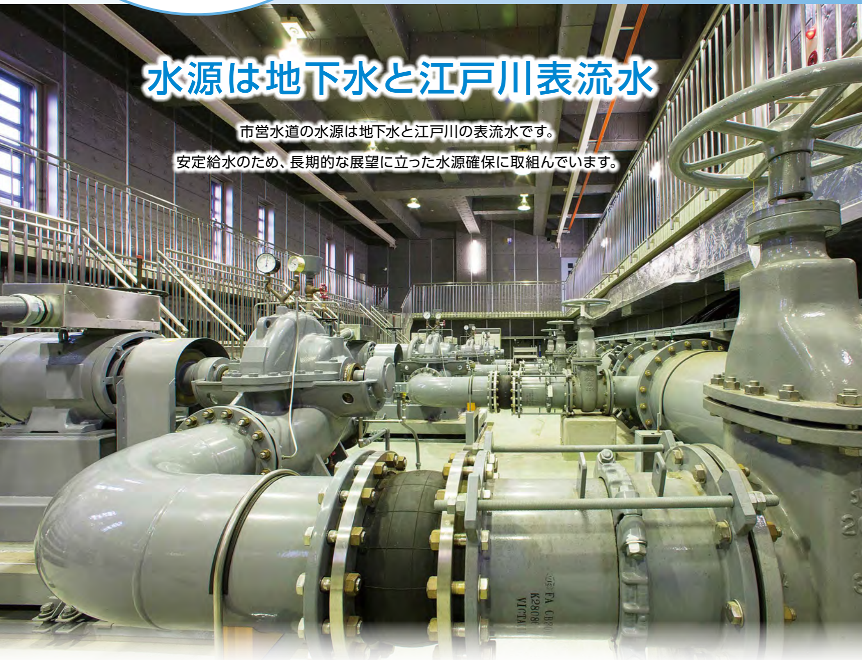
配水ポンプ (第2給水場)
