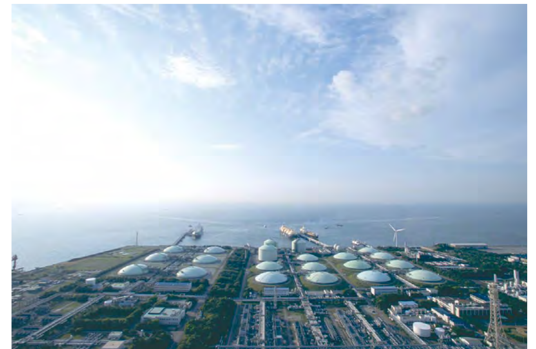
外国産液化天然ガスを受け入れる袖ヶ浦基地（東京ガス）
