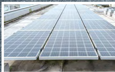
屋上ソーラーパネル
