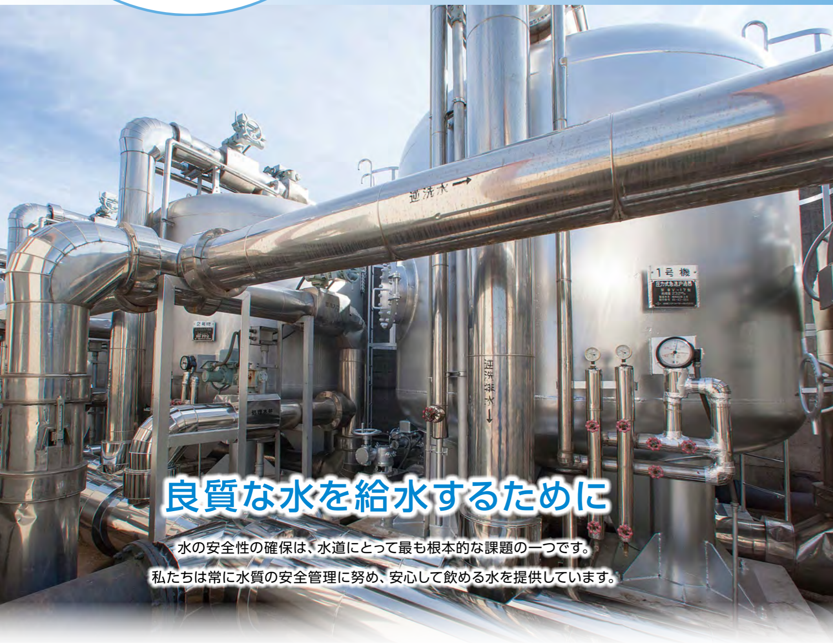
第1給水場急速ろ過装置
