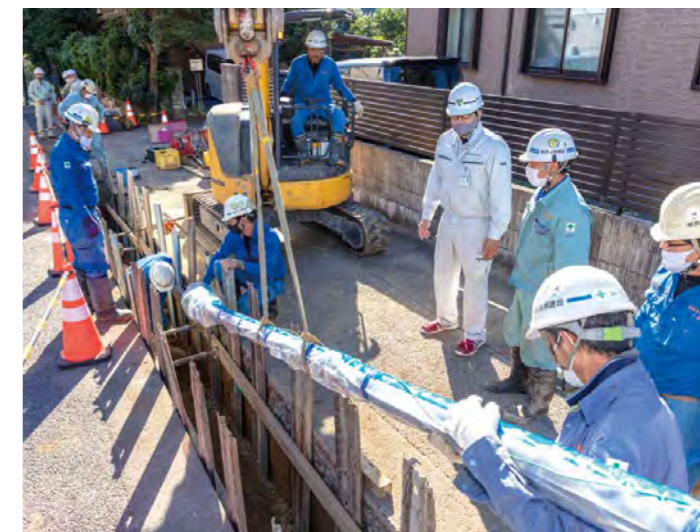
配水管入替工事
