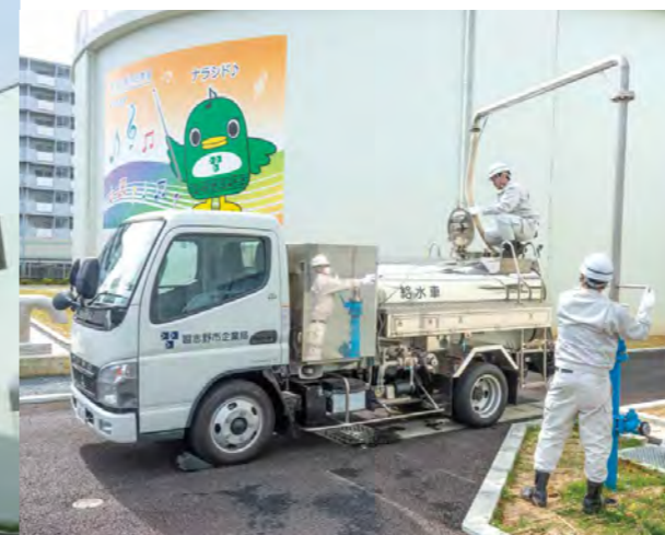
応急給水設備
