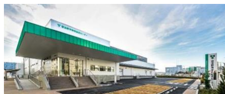
給食センター・習志野市HPより
