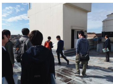
屋上にも補修の跡が見られます
