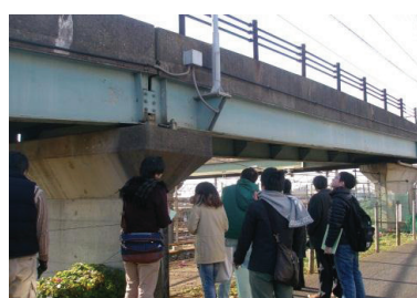
鷺沼東跨線橋
