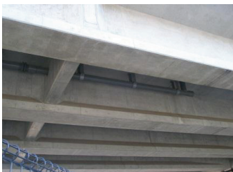
中央公園橋の排水設備
