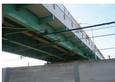
鷺沼中央跨線橋
