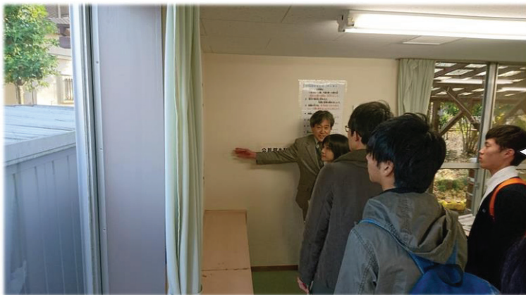
壁の中耐震工事しています
