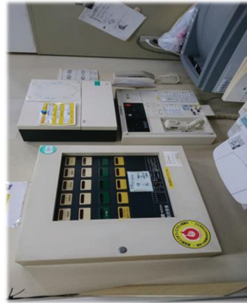
新習志野公民館非常放送設備交換工事
