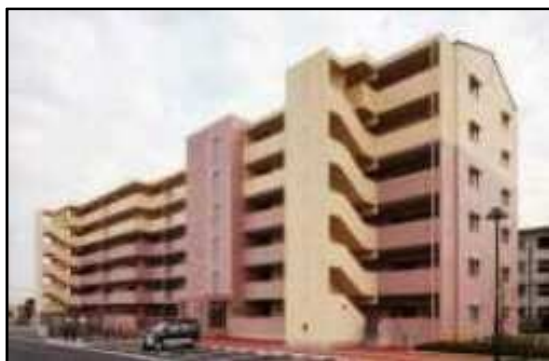
例：鉄筋コンクリート造（耐火建築物）
