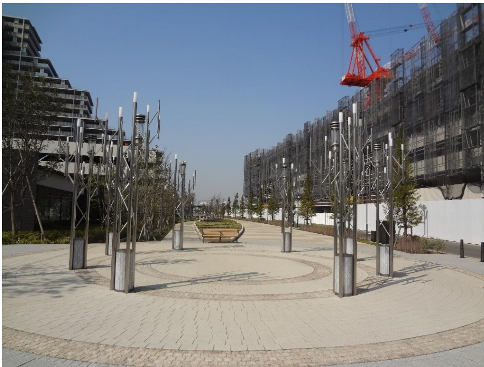
16m プロムナードに設置されたガス
