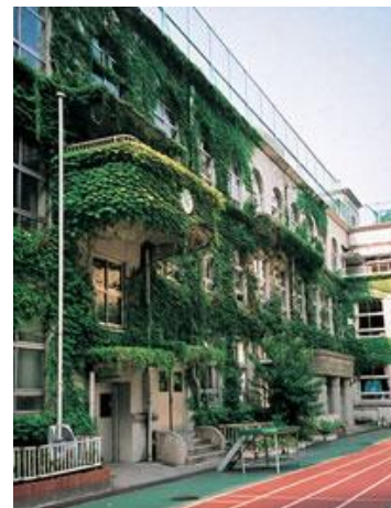
壁面緑化の例(出典：中央区)
