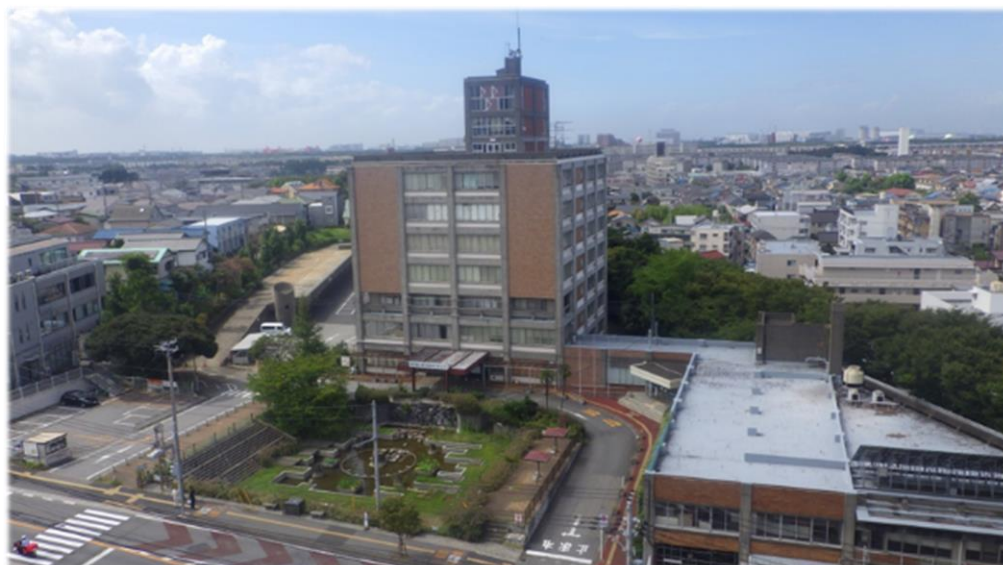
◆旧庁舎全景(解体作業前)
