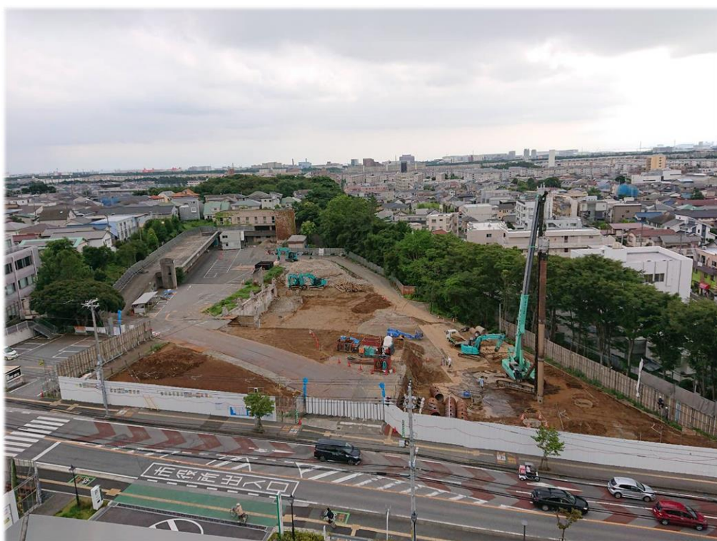
◆旧庁舎跡地(解体作業中)
