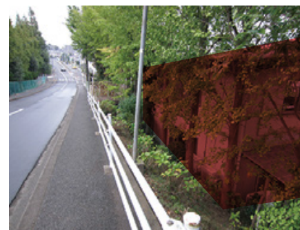
既存建物と擁壁が近い。
