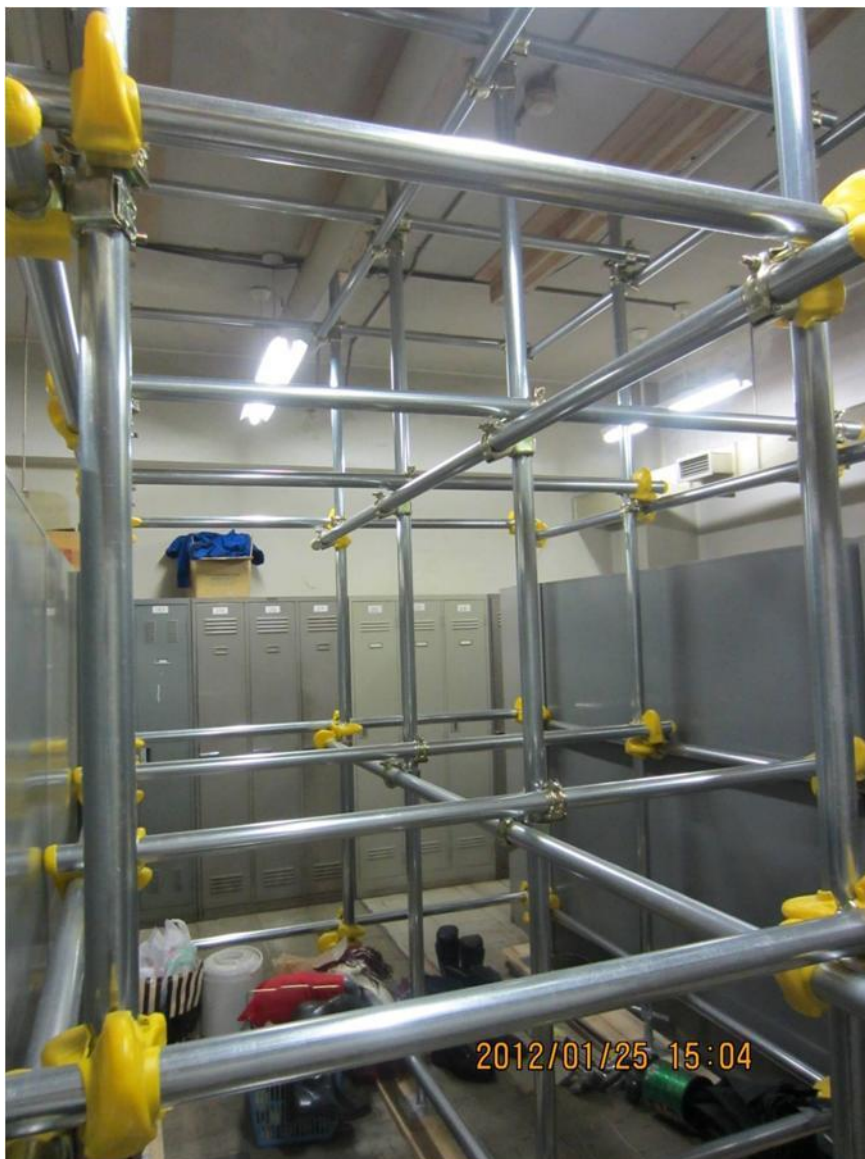
1 階の床を地下からさせている様子 (その 2)
