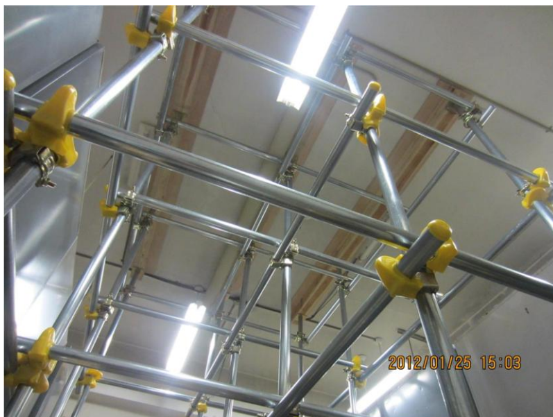
1 階の床を地下からさせている様子 (その 2)
