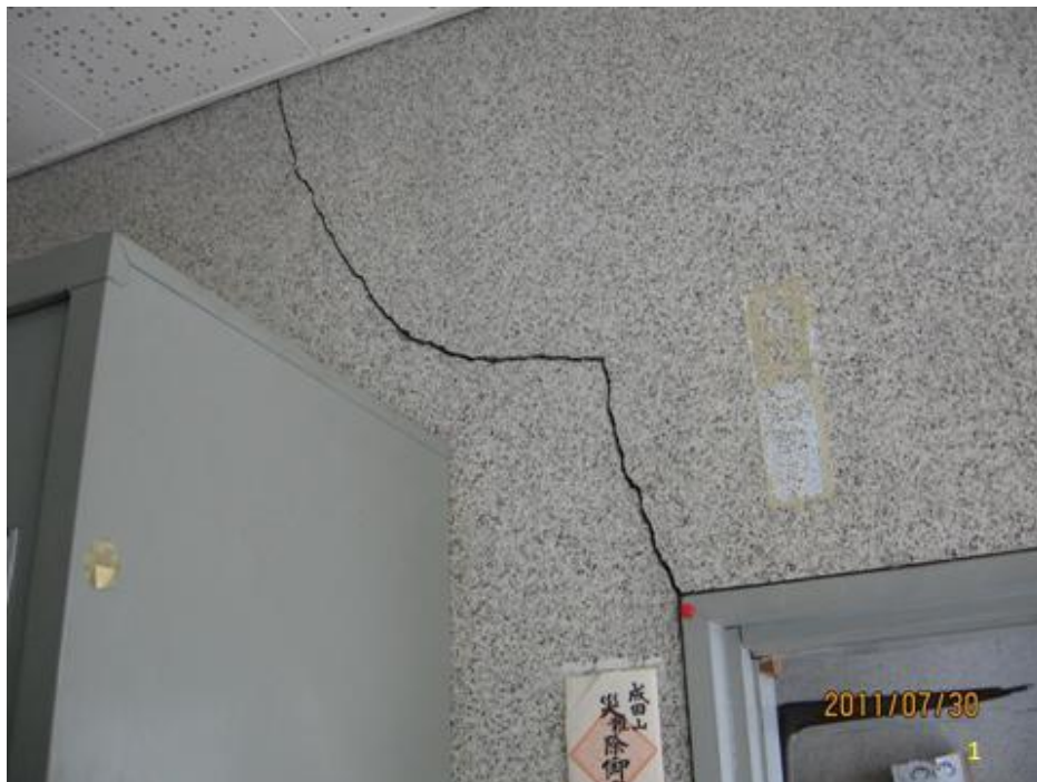
壁面のひび割れ
