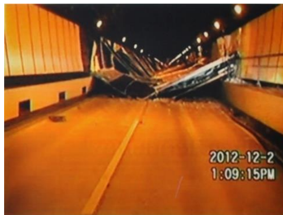
2012.12.2 中央道笹子トンネル 天井板崩落 9名死亡
