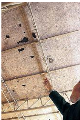
2012.11.25 輪島市上野台中体育館 天井崩落
