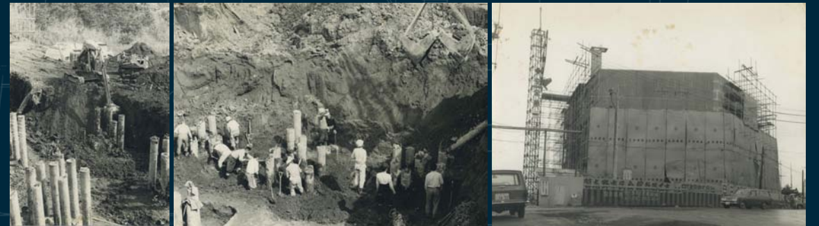
基礎工事と建築の様子
