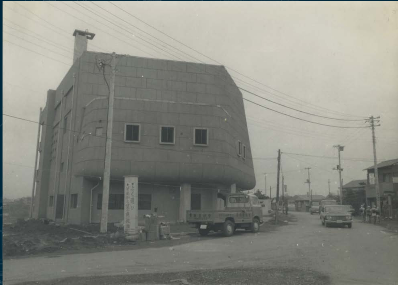
正面入口(北側 京成大久保駅側)
