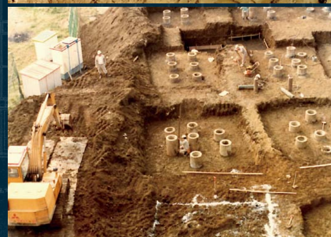
基礎工事と建築の様子
