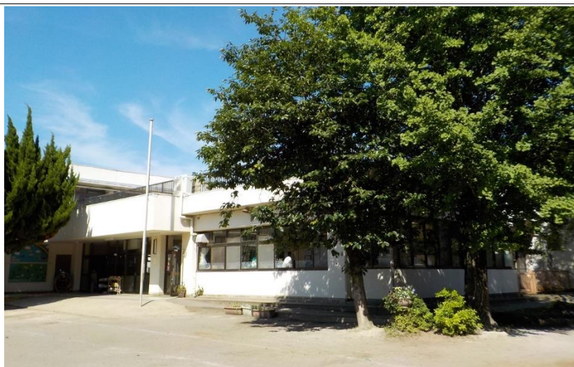
工事前 ※令和6年6月撮影
