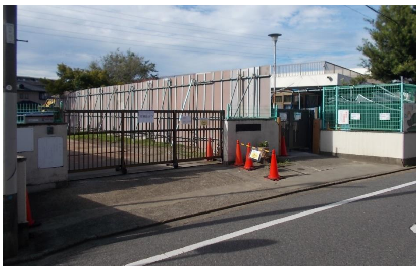
工事中 ※令和6年10月撮影
