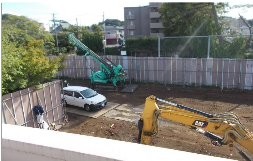
工事中（藤崎保育所屋上から） ※令和6年10月撮影
