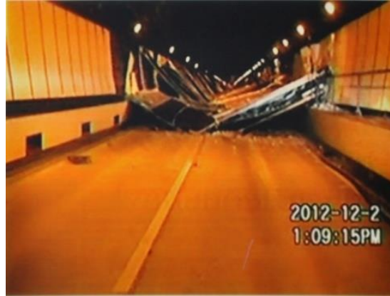
2012.12.2 中央道笹子トンネル 天井板崩落
