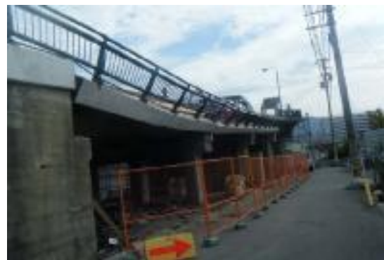
2011.10.25 福岡県直方市 陸橋崩落
