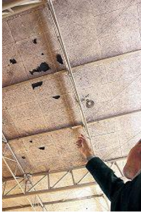
2012.11.25 輪島市上野台中体育館 天井崩落
