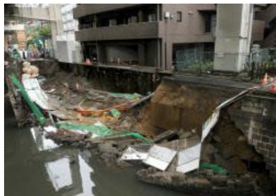
2013.10.15 東京都港区 区道崩落
