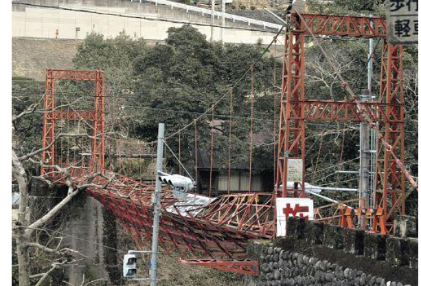
2013.2.10 浜松市第一弁天橋 ワイヤー破断
