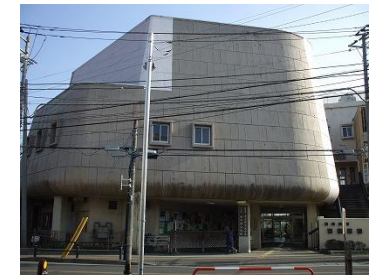
昭和41年建築の 大久保公民館・市民会館
