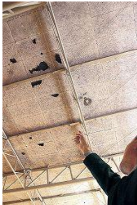
2012.11.25 輪島市上野台中体育館 天井崩落
