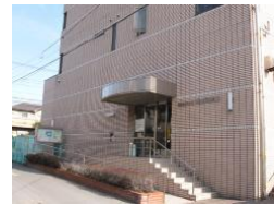
1992（平成4） 藤崎図書館
