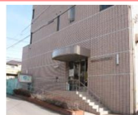
1992(平成4)年 藤崎図書館
