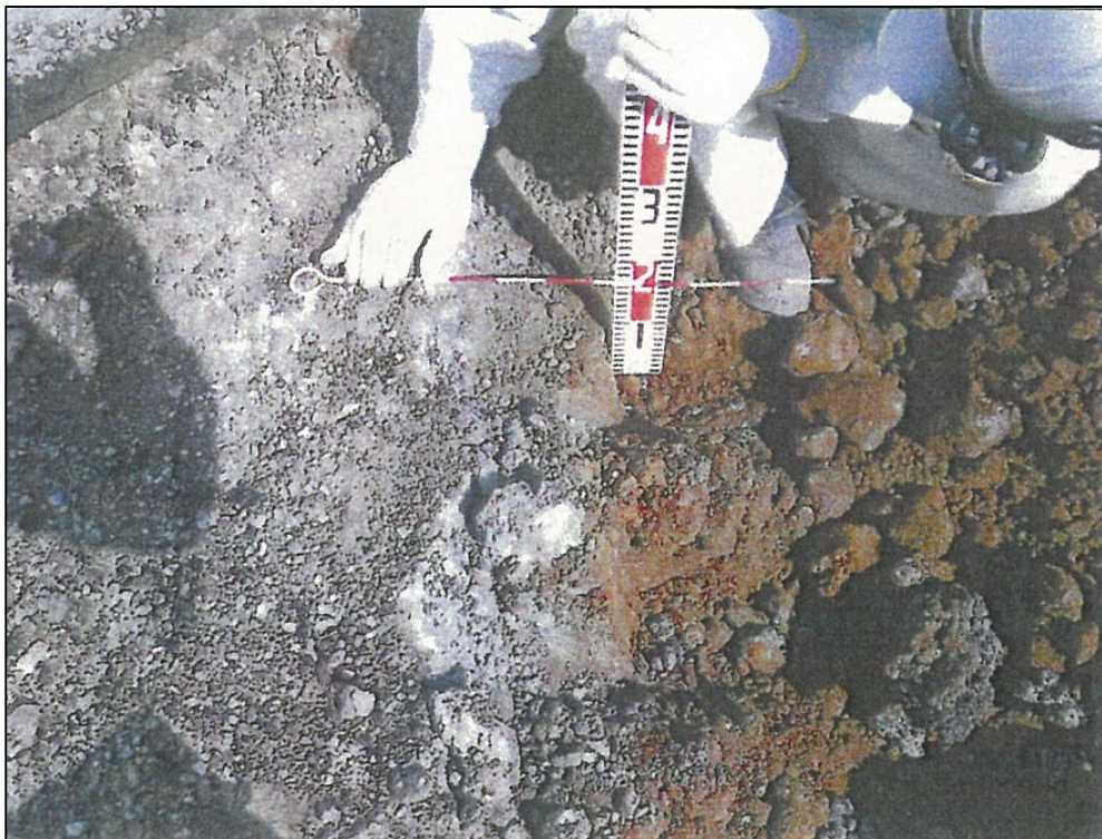
写真 1.2 (4) 鉋さい状況 (近景)
