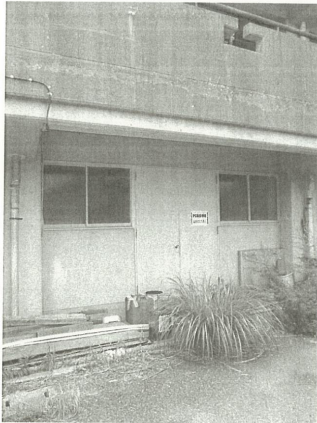
▲習志野市役所旧庁舎内、P C B保管場所（外部）
