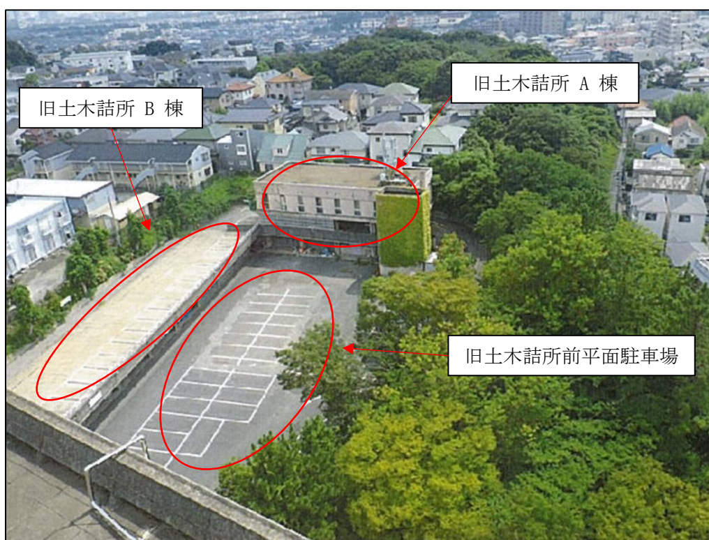
写真 1.2 (6) 工事前状況 (旧土木詰所)
