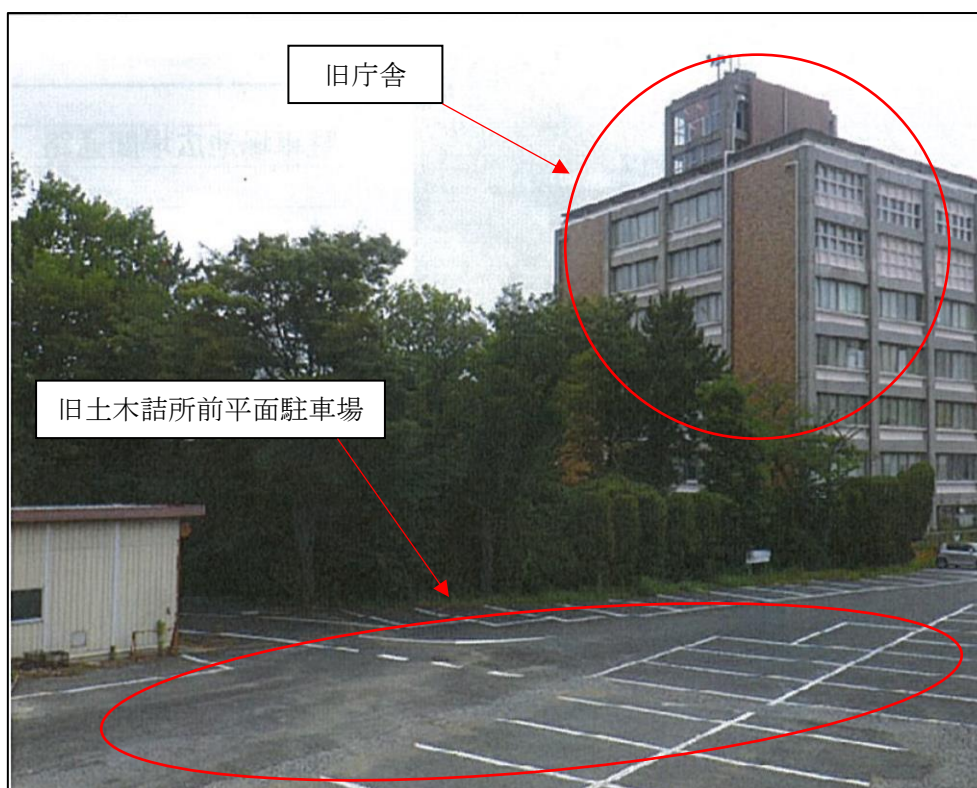
写真 1.2 (5) 工事前状況 (旧庁舎)
