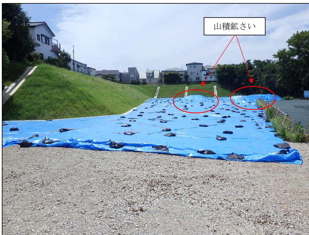
写真 1.2 (1) 飛散防止ブルーシート状況（北側より撮影）
