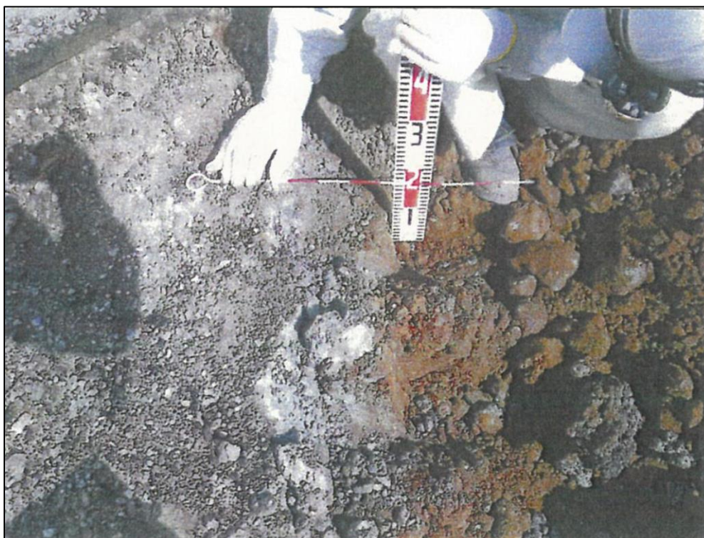
写真 1.2 (4) 鉋さい状況（近景）
