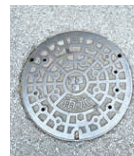
▲雨水管のマンホールは「雨水」の文字が目印です。
