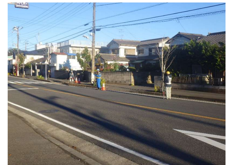
路面高さ測定状況
