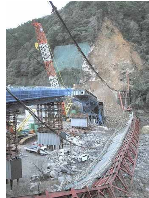
2015.1.31 浜松市原田橋 崩落 2名死亡
