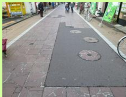
大久保商店街の路面補修
