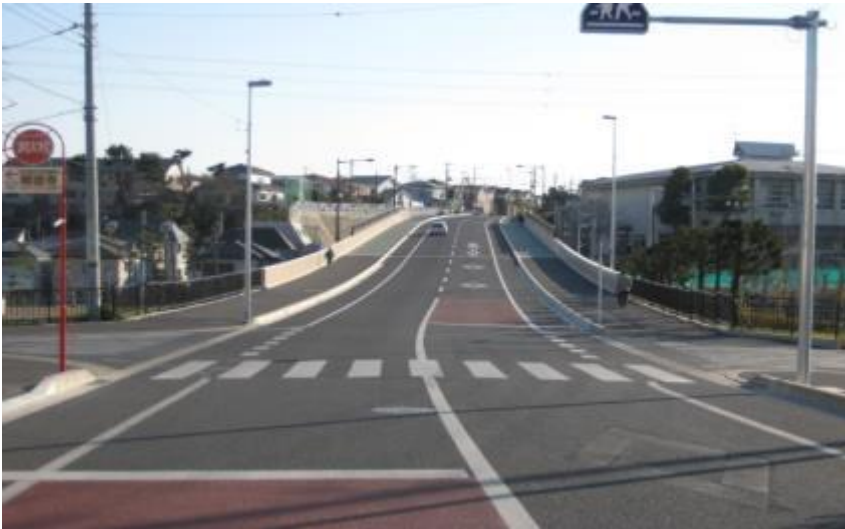
② 整備済区間（京成大久保駅方面3・4・11号線から中央公園橋を望む）
