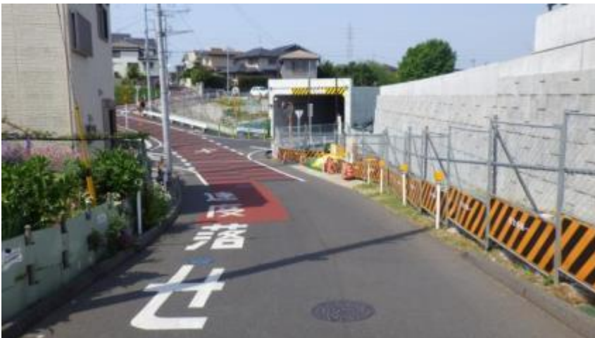
③ 令和3年度以降施工箇所
