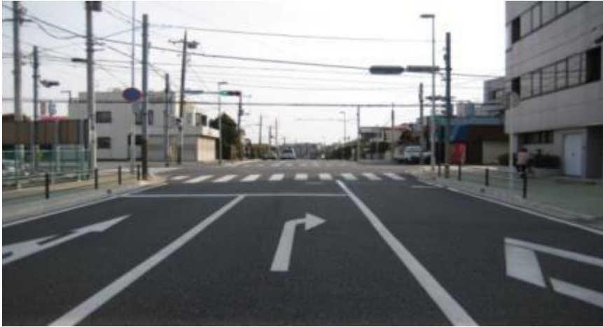
① 整備済区間（京成大久保駅方面から3・4・11号線を望む）
