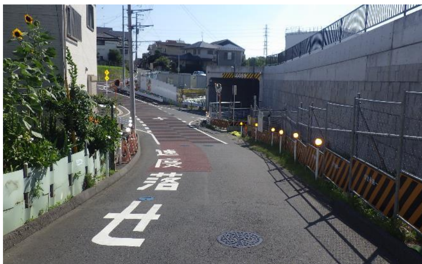
③ 未整備区間
