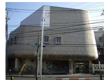
昭和41年建築の 大久保公民館・市民会館
