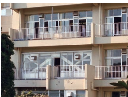
耐震化工事をした学校
