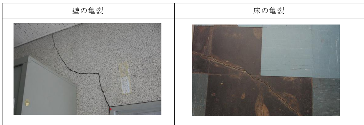
図 1.1-1 本庁舎の状況写真
