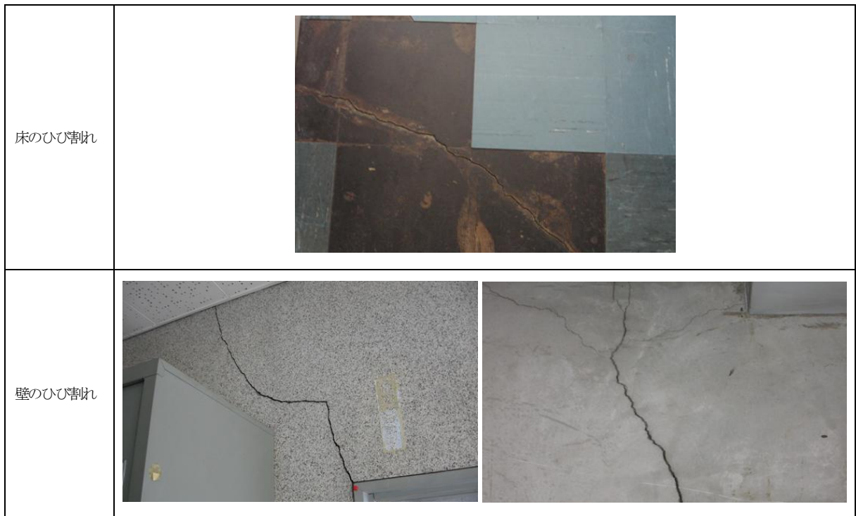
図 1.1-1 現庁舎の状況写真
