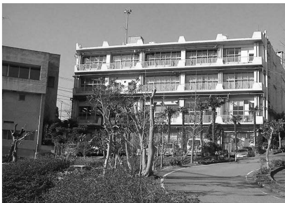
中央公園から見た大久保公民館・市民会館
