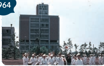
地下1階、地上7階建ての鉄筋コンクリート造の市役所が完成
